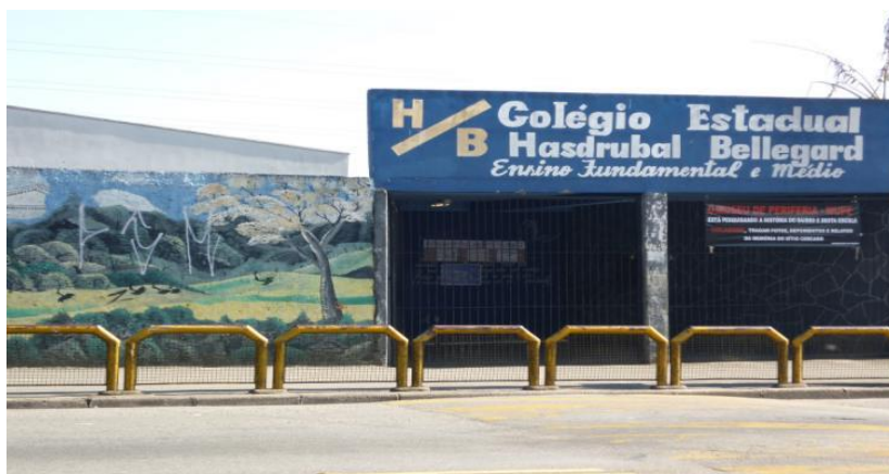
FIGURA 1 – Fachada do Colégio Estadual Hasdrubal Bellegard. (Fonte: SEED PR, 2012).
